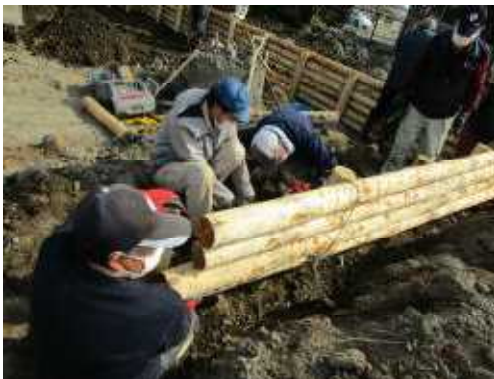
【3/7 みんなで力を合わせて丸太を組み、たった1日で池の縁がきれいに】
