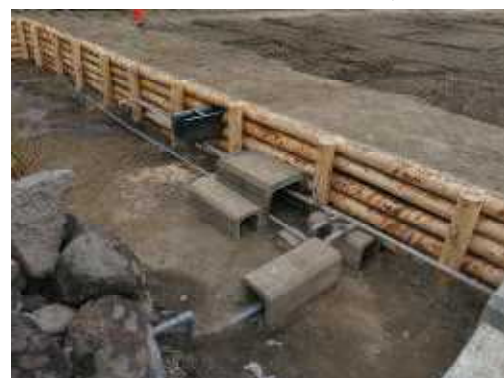
【組み直された取水口と魚道】
