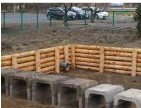
【縁の丸太組みと排水口】
