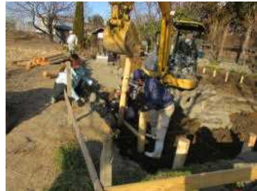
【3/7 みんなで力を合わせて丸太を組み、たった1日で池の縁がきれいに】
