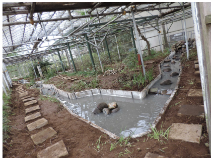
－ 工事完成後のビオトープ －
