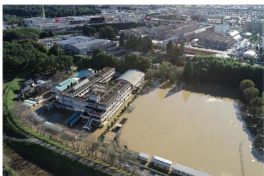
令和元年東日本台風時の浸水被害
