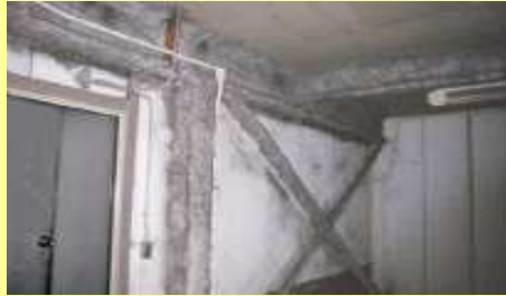
（柱・梁・天井などに吹付けられたアスベストの例）
