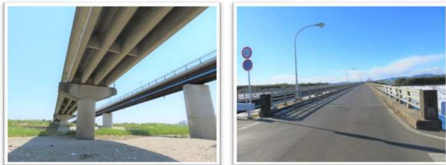
対象施設の一例（石ノ上橋・石ノ上さくら橋）
