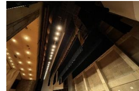
大ホール舞台吊物
