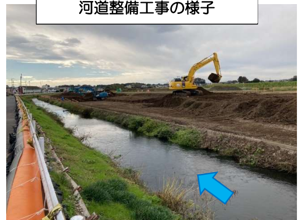
河道整備工事の様子
