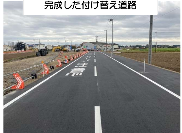
完成した付け替え道路
