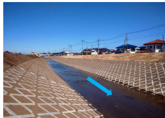
大日橋下流の工事完了区間の様子
