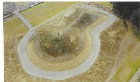
令和 4 年度までの施工状況
