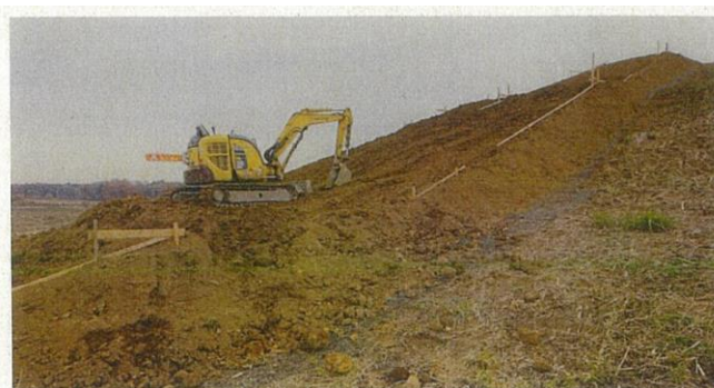
墳丘盛土施工状況(西から)
