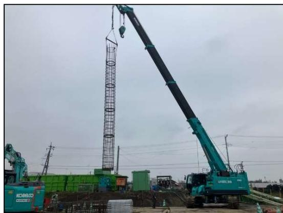
大行寺橋基礎杭(鉄筋建込)施工状況
