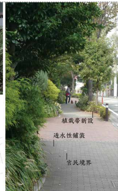
竣工12年を経た外構と外周道路。2011/10/04
