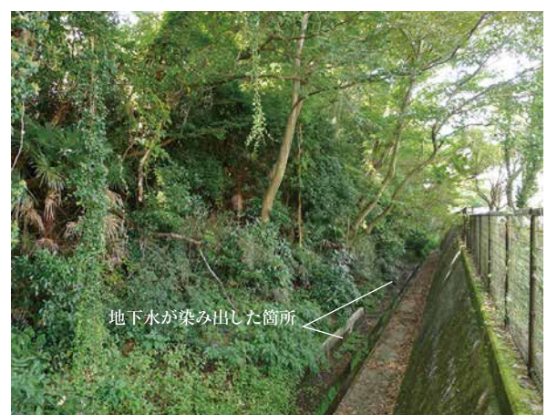
写真1 台地斜面から地下水が染み出す状況を写す。2021/10/06 外城
