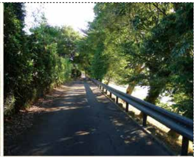
水害防備林。下生井、生井地区
