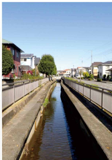
水路(間々田地区)
