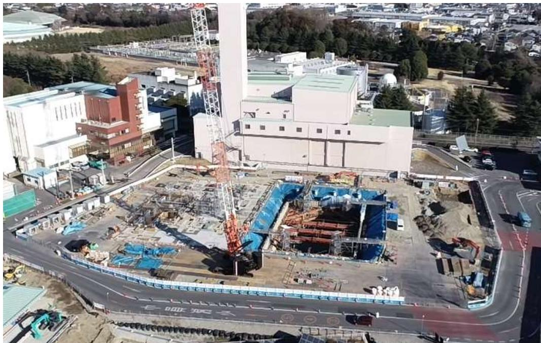
工事概要：ごみピット内部の基礎、周囲の地下部の基礎を進めています。2月も引き続き基礎工事を行う予定です。
