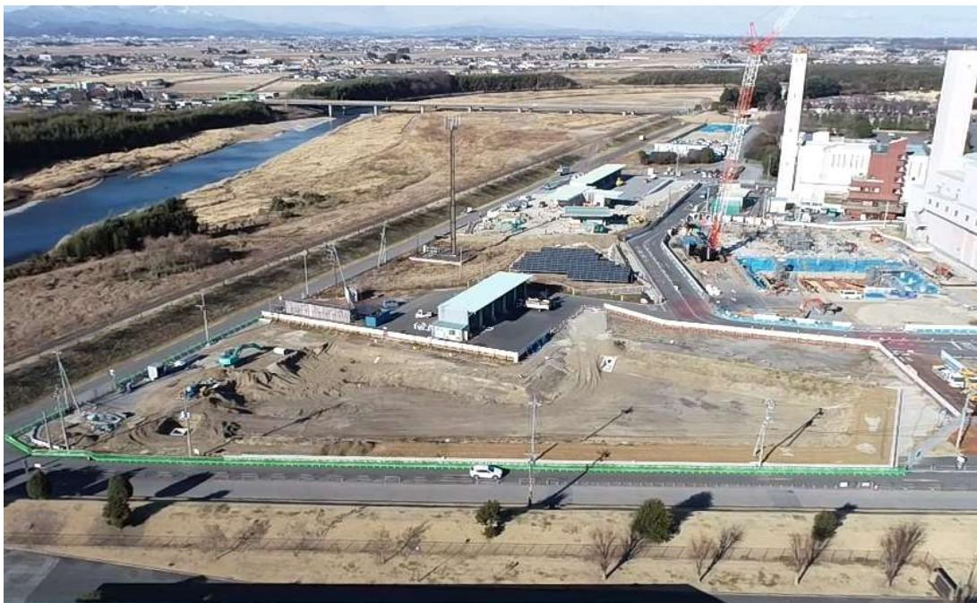
工事概要：12月から調整池の雨水を排出する放流管の設置工事を行っています。また、放流管上部の擁壁工事を行っています。
