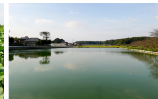
水量調整。ため池による。
