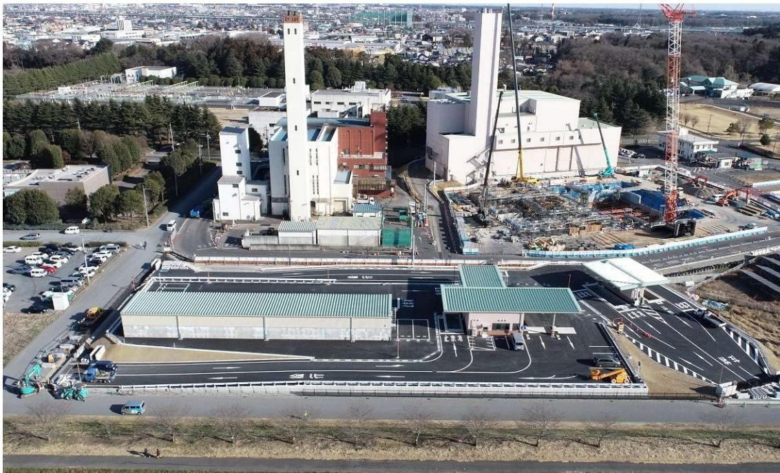
工事概要：場内の舗装も完了し、建築物の工事は完成間近となりました。現在は計量機等のプラント機器を設置しております。3月は引き続きプラント機器工事と外構工事を行う予定です。
