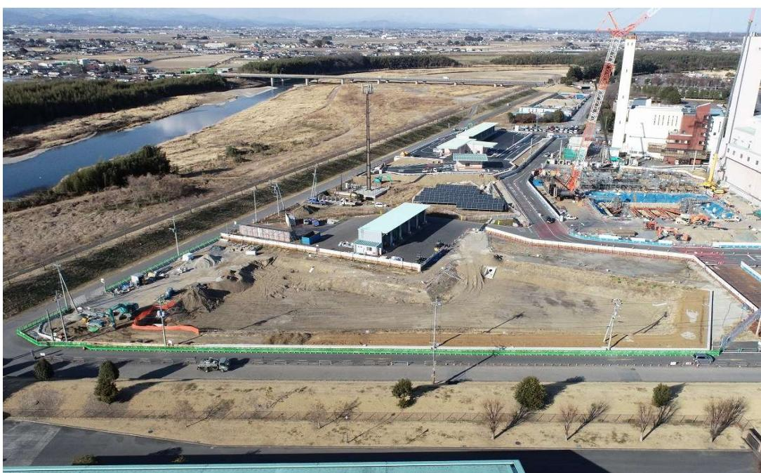
工事概要：工事用ゲート付近の切土とメンテナンス用通路の造成を行っております。ゲート付近の擁壁は2月中に行う計画です。3月には法面の芝張りや灌水設備の設置工事を行う予定です。
