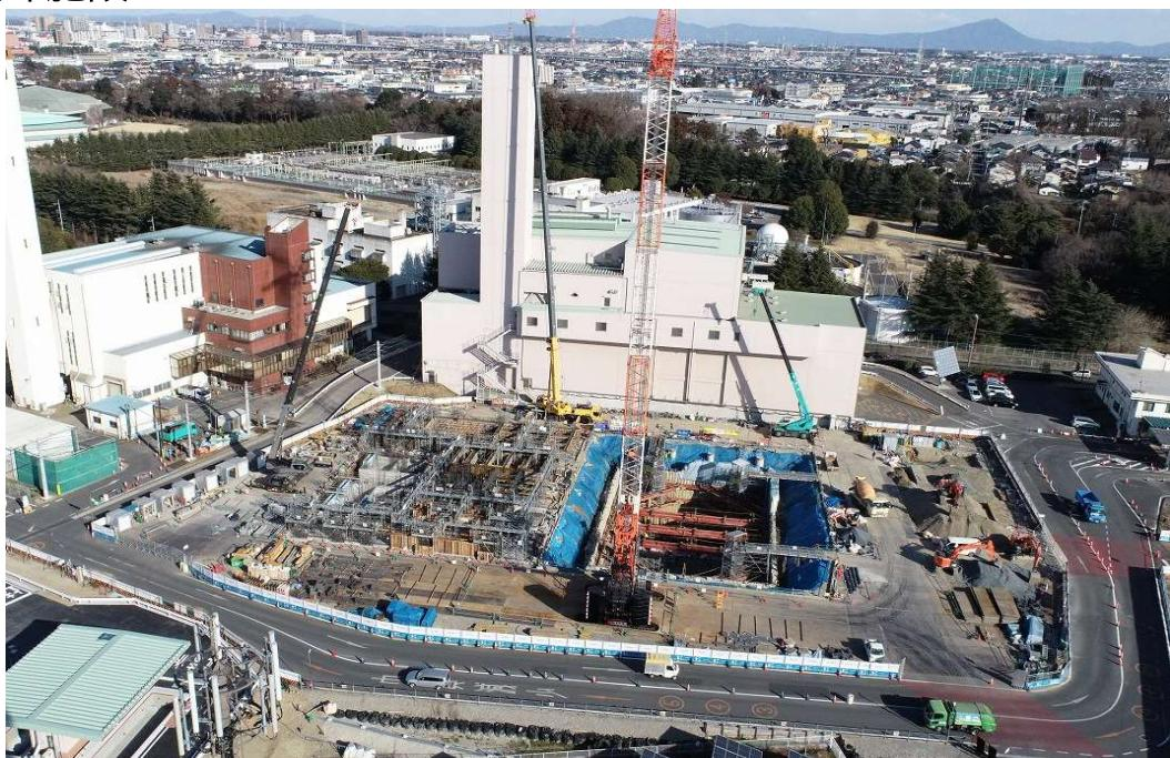
工事概要：ごみピット内部の基礎、周囲の地下部の基礎を引き続き進めています。3月も引き続き基礎工事を主に実施いたします。
