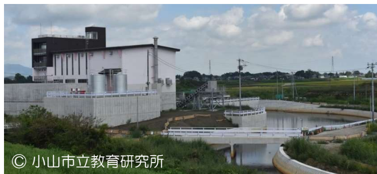
完成した総合排水機場
