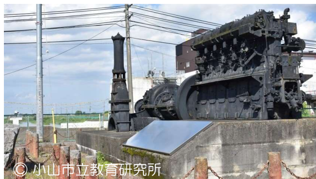
旧排水機場で使用されたポンプ(第1排水機場内)
