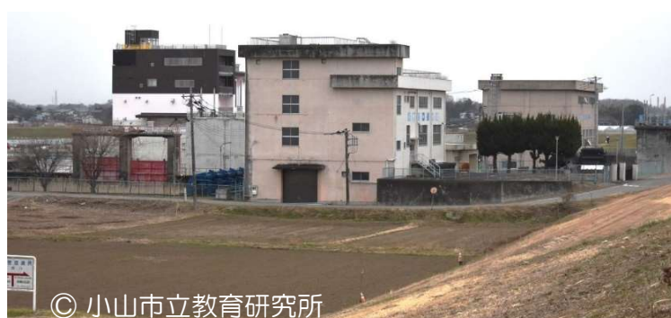
西側から、総合(左奥)、第1(手前)、第2(右奥) 〔2023年2月10日撮影〕
