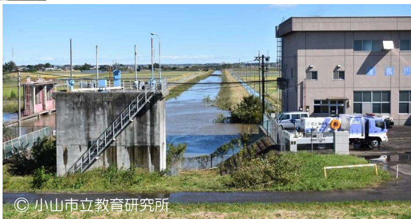
台風時の排水機場〔2019年10月13日撮影〕
