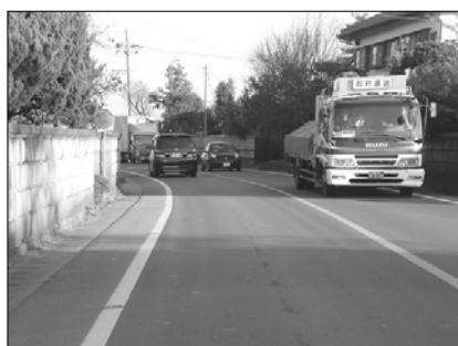
グリーンベルト（現況）
