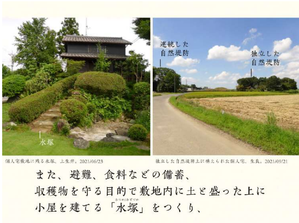
図 24 自然堤防上の家屋敷地にさらに盛土をしてもうける水塚（みつか/みずづか）
