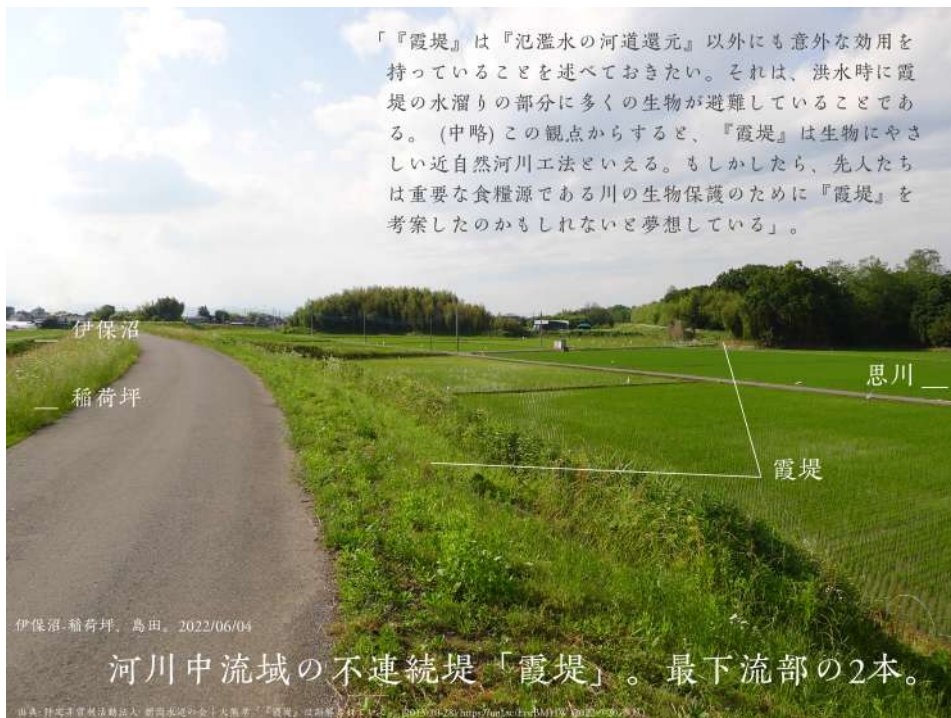
図9 「霞堤」は不連続の堤防で、河川中流域では上流であふれた水を川へ戻す機能を持つ
