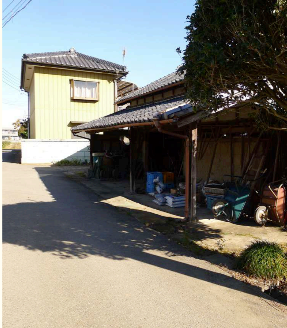
集落内の道に開かれた納屋の下屋、松沼。2022/11/12
