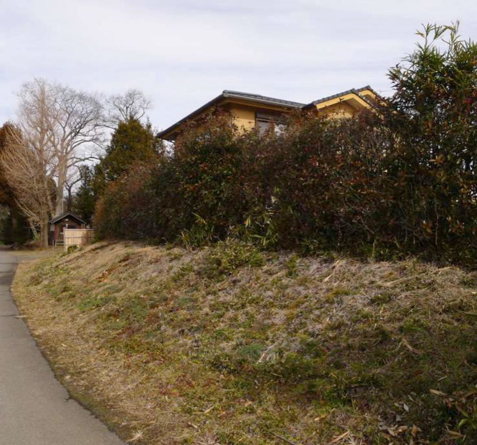
民家に設けられた堤防状の盛土。舟戸。2024/01/22
