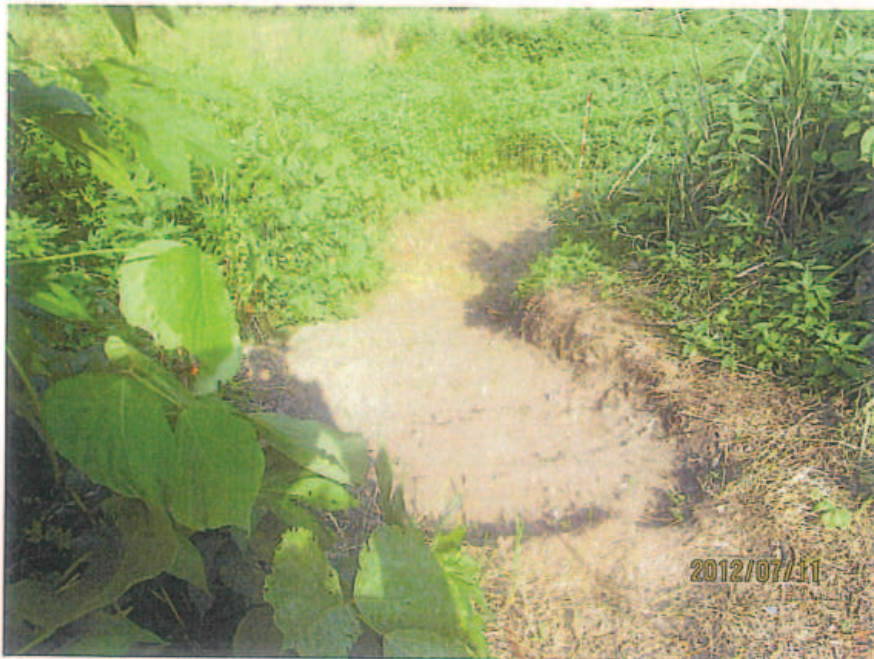
搬入路整備状況
