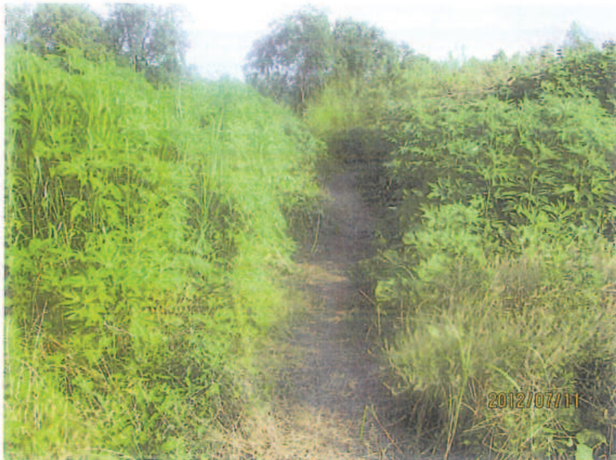
搬入路整備状況
