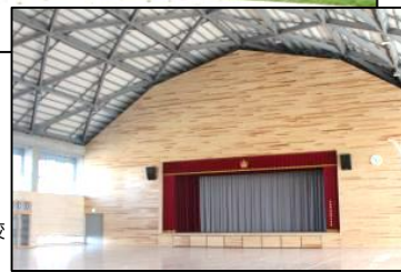
豊田小学校 体育館
