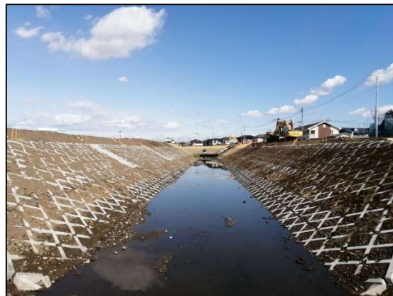
河道整備施工状況 新川橋上流 R7.2月時点
