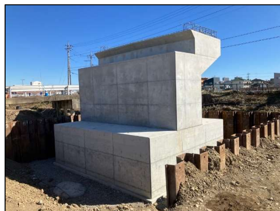
大行寺橋施工状況 橋台(左岸側) R7.2月時点
