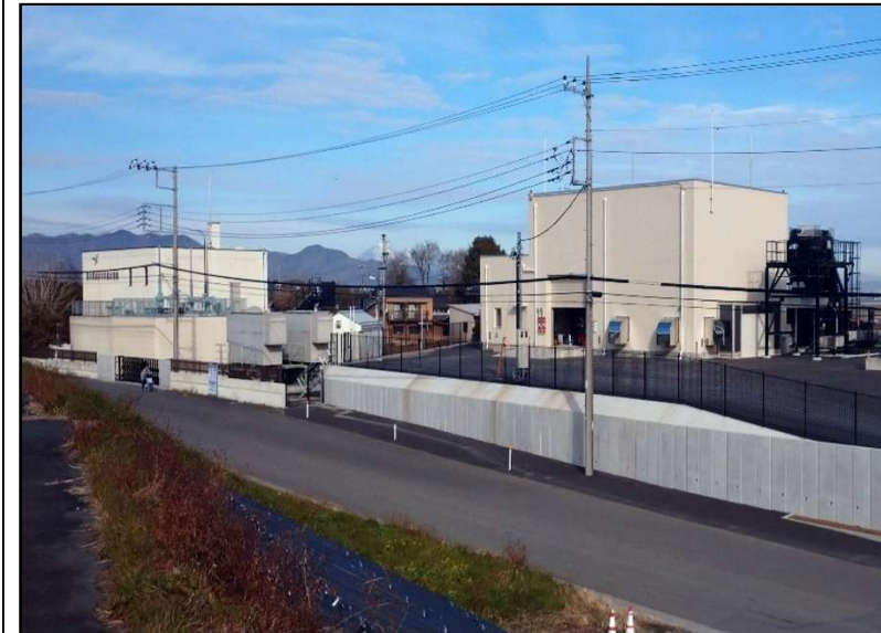
杣井木川排水機場 外観
