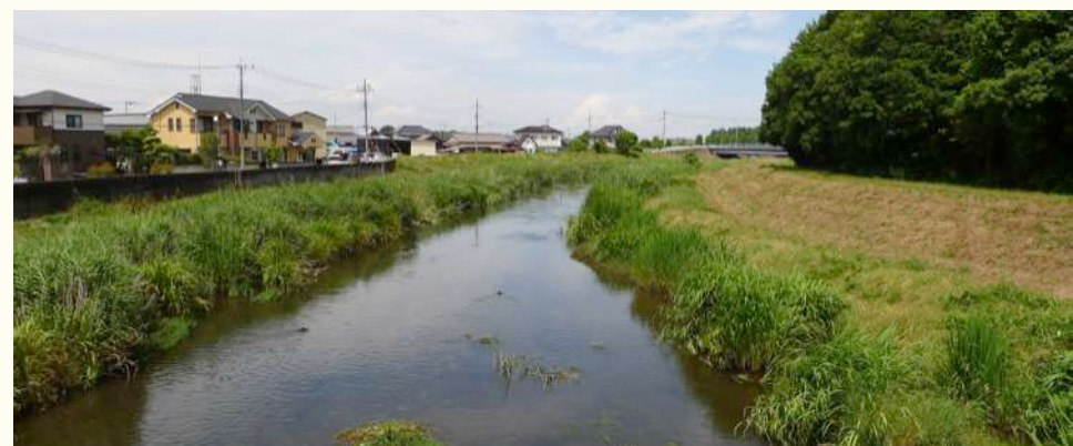
かつての本沢橋(現螢橋)から上流側を見る。上泉。2024/06/24
