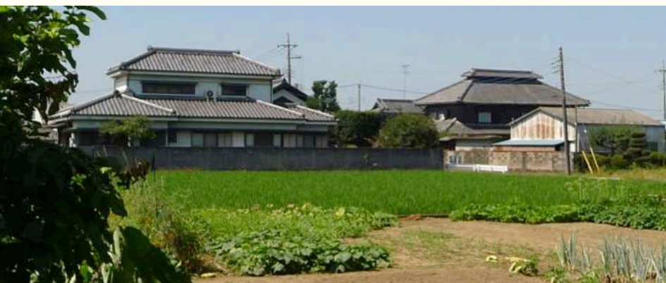
棟に沿って長く気抜きを設けた例 (写真左手の木はクワ)。同上
