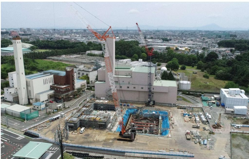
工事概要：ごみピット内部の壁を打設しております。壁の打設は、8月中旬まで続く予定です。ゴミピット北の建物は、1階フロアの壁打設の準備を行っています。
