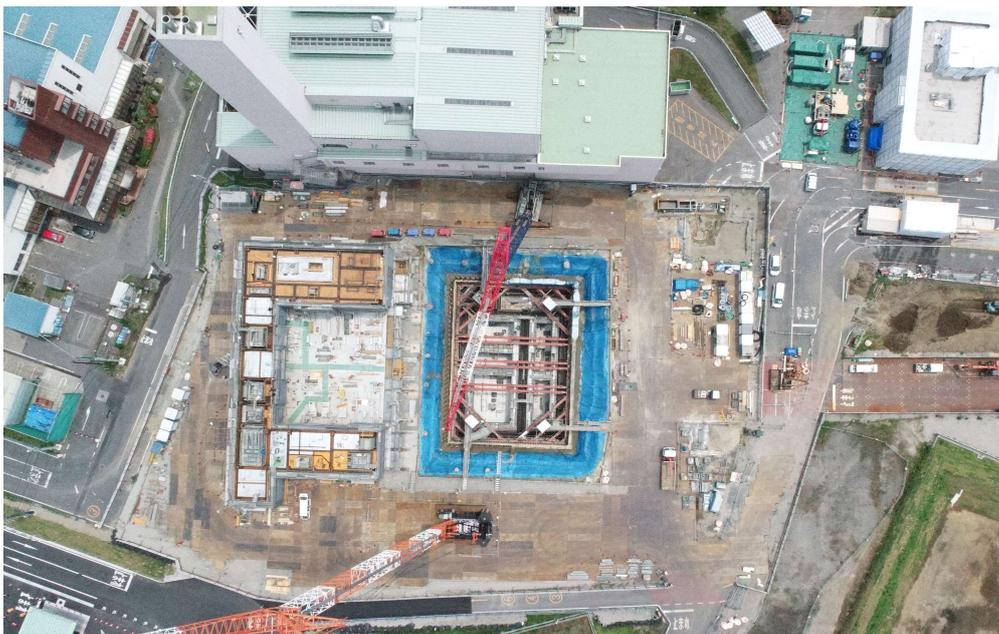
工事概要：ゴミピットでは、4月よりも内部足場がはっきり見えません。壁の打設を行っているので、内部足場が壁に合わせて高くなっています。施設北側の黄土色に見える部分は、型枠です。1階の壁から2階の床面を打設する準備を進めています。
