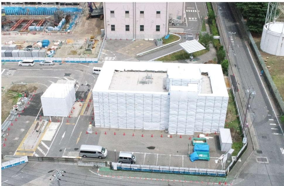
工事概要：旧管理棟エリアでは、アスベスト除去工事が行われています。施設周辺からアスベストが漏れないよう、周囲を厳重に養生しています。細心の注意を払って施工を進めております。
