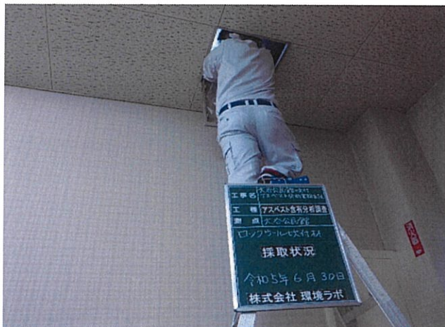
大谷公民館 天井裏 ロックウール吹付材 採取状況
