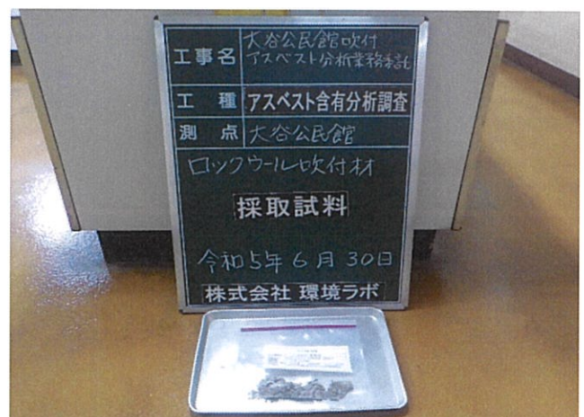
大谷公民館 天井裏 ロックウール吹付材 採取試料
