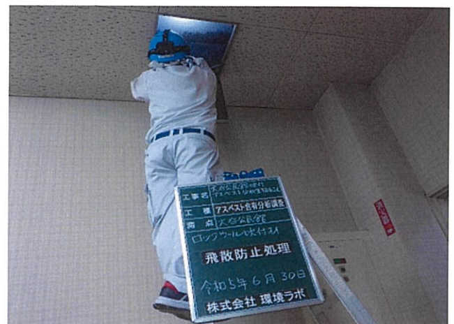
大谷公民館 天井裏 ロックウール吹付材 飛散防止処理
