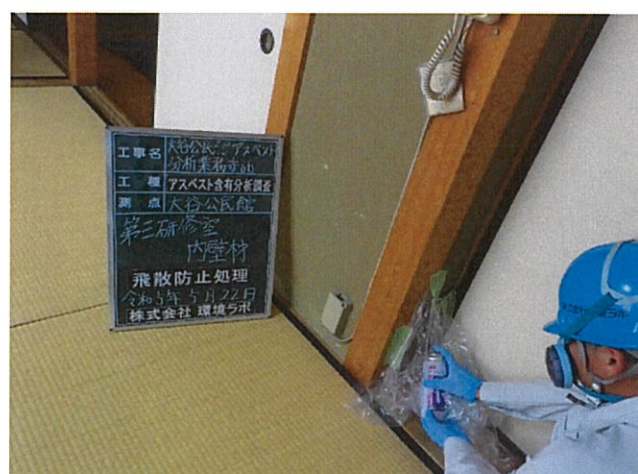
大谷公民館 第三研修室 内壁材 飛散防止処理
