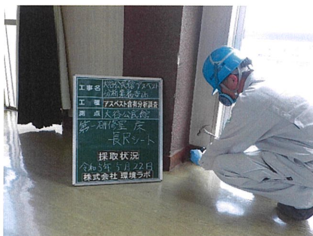
大谷公民館 第一研修室 床 長尺シート 採取状況
