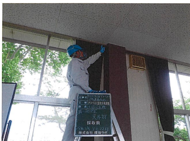
大谷公民館 第一研修室 天井 天井材 採取前
