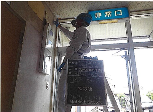
大谷公民館 通路 天井 天井材 採取後
