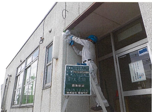
大谷公民館 軒天 軒天塗材 採取状況
