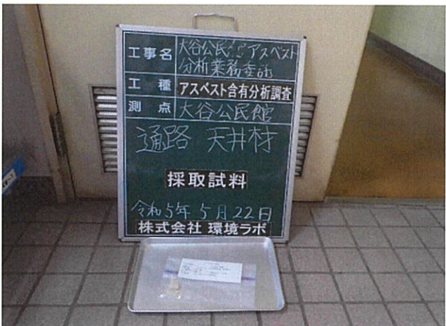
大谷公民館 通路 天井 天井材 採取試料
