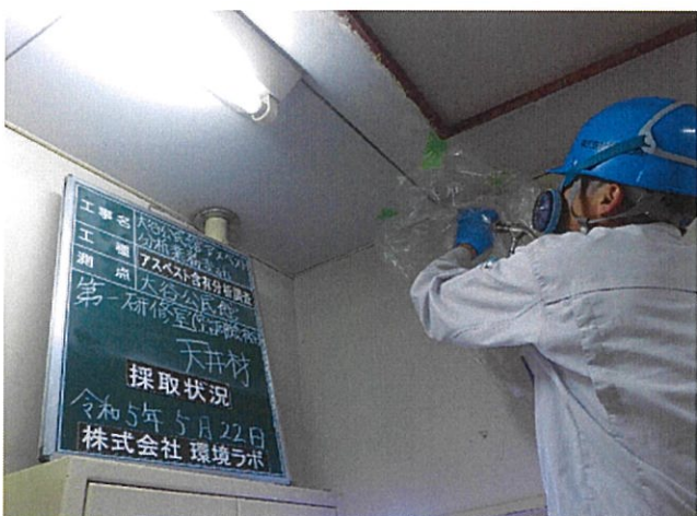
大谷公民館 第一研修室(空調機械室) 天井材 採取状況
