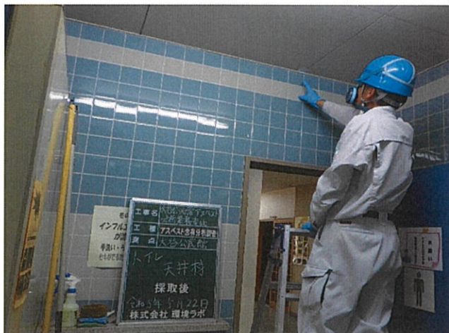
大谷公民館 トイレ 天井 天井材 採取後
