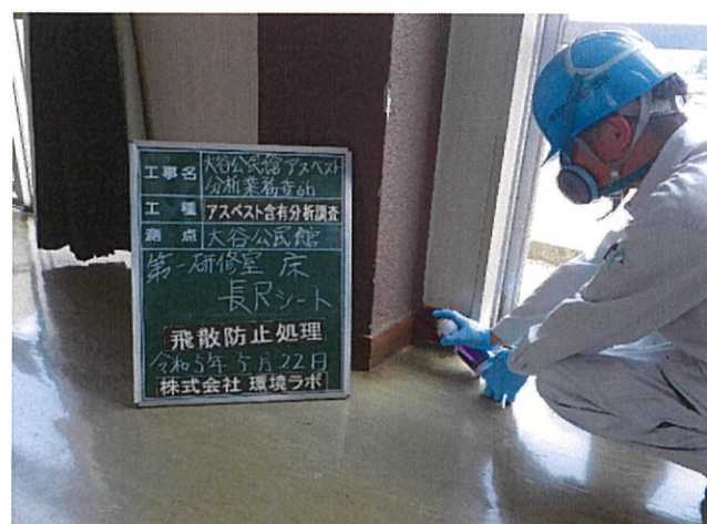
大谷公民館 第一研修室 床 長尺シート 飛散防止処理
