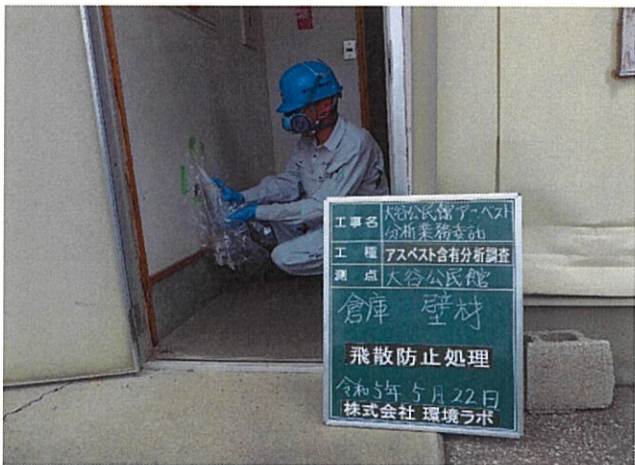
大谷公民館 倉庫 内壁 壁材 飛散防止処理
