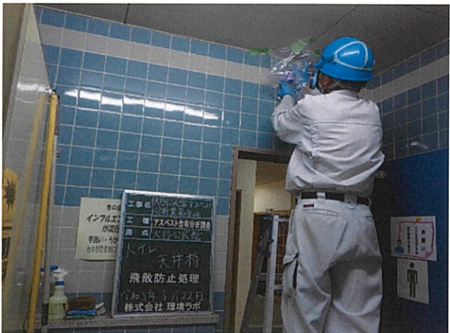
大谷公民館 トイレ 天井 天井材 飛散防止処理
