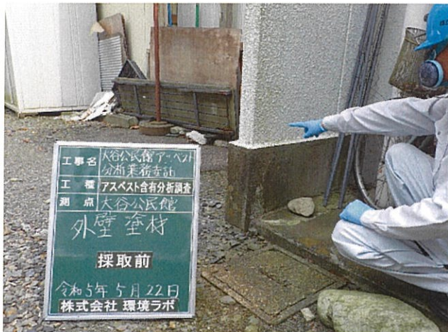
大谷公民館 外壁 外壁塗材 採取前
