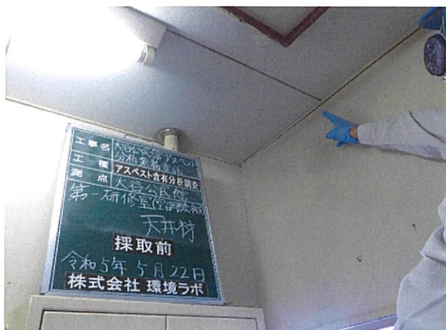
大谷公民館 第一研修室(空調機械室) 天井材 採取前
