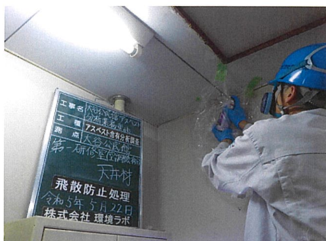
大谷公民館 第一研修室(空調機械室) 天井材 飛散防止処理
