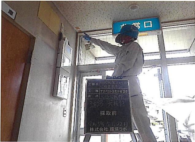
大谷公民館 通路 天井 天井材 採取前
