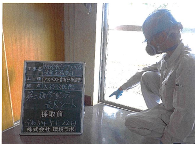
大谷公民館 第二研修室 床 長尺シート 採取前
