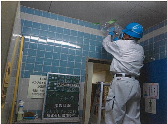
大谷公民館 トイレ 天井 天井材 採取状況
