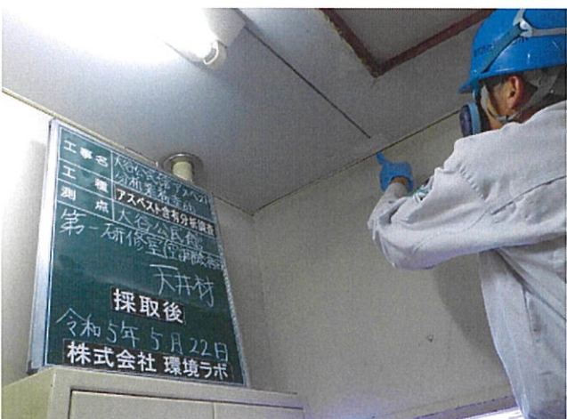
大谷公民館 第一研修室(空調機械室) 天井材 採取後
