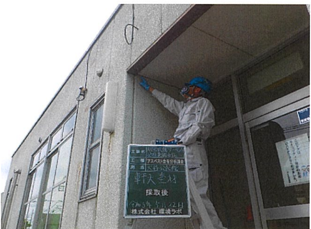
大谷公民館 軒天 軒天塗材 採取後
