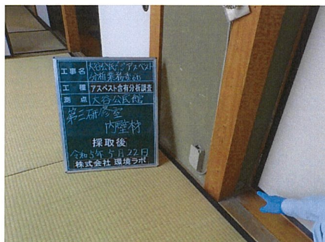
大谷公民館 第三研修室 内壁材 採取後
