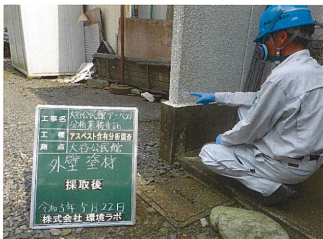
大谷公民館 外壁 外壁塗材 採取後
