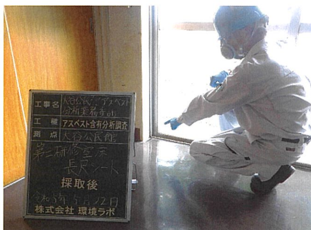
大谷公民館 第二研修室 床 長尺シート 採取後
