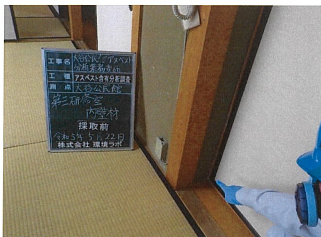
大谷公民館 第三研修室 内壁材 採取前
