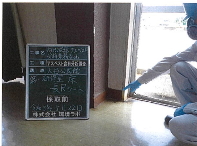
大谷公民館 第一研修室 床 長尺シート 採取前
