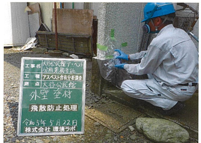
大谷公民館 外壁 外壁塗材 飛散防止処理
