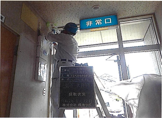
大谷公民館 通路 天井 天井材 採取状況
