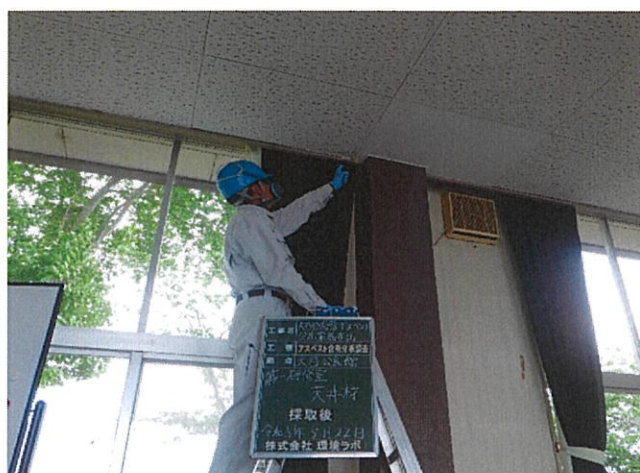
大谷公民館 第一研修室 天井 天井材 採取後
