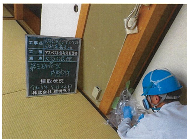
大谷公民館 第三研修室 内壁材 採取状況
