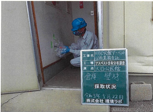
大谷公民館 倉庫 内壁 壁材 採取状況
