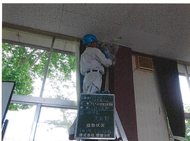
大谷公民館 第一研修室 天井 天井材 採取状況
