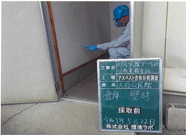
大谷公民館 倉庫 内壁 壁材 採取前
