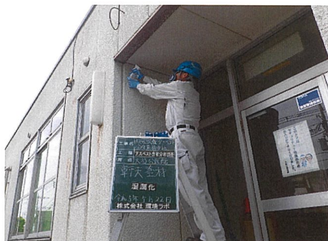
大谷公民館 軒天 軒天塗材 湿潤化
