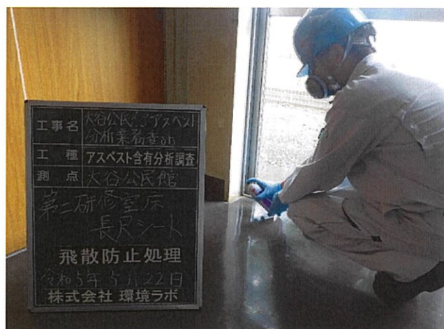
大谷公民館 第二研修室 床 長尺シート 飛散防止処理
